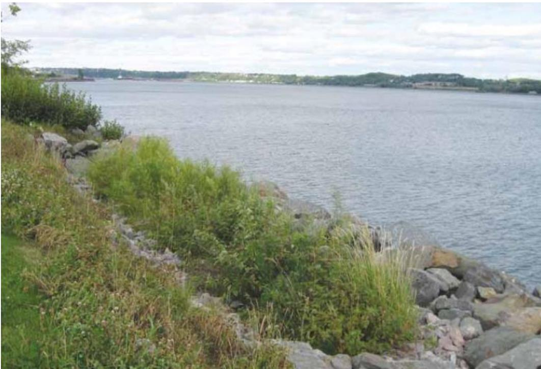
Figure 14. Illustration d'un exemple d'une stabilisation et reprofilage d'un talus. Source : Écogénie.
