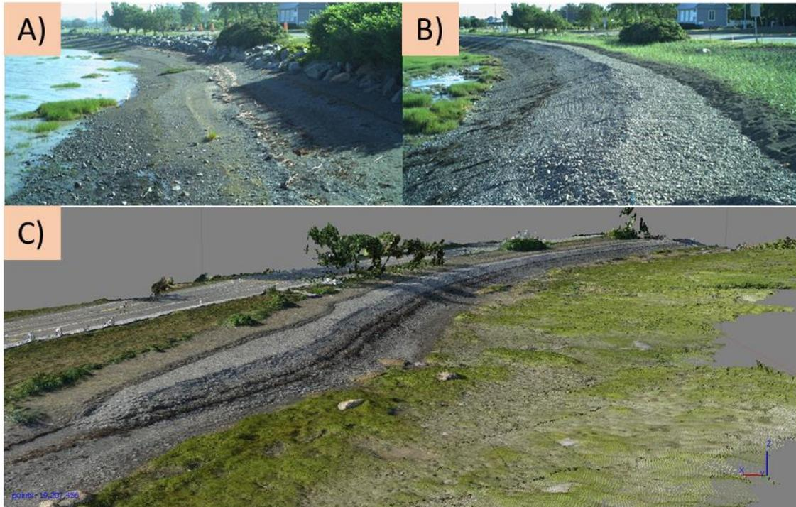
**Figure 11.** La plage de l’Anse-du-Portage avant (A) et après les travaux de recharge sédimentaire (B).
