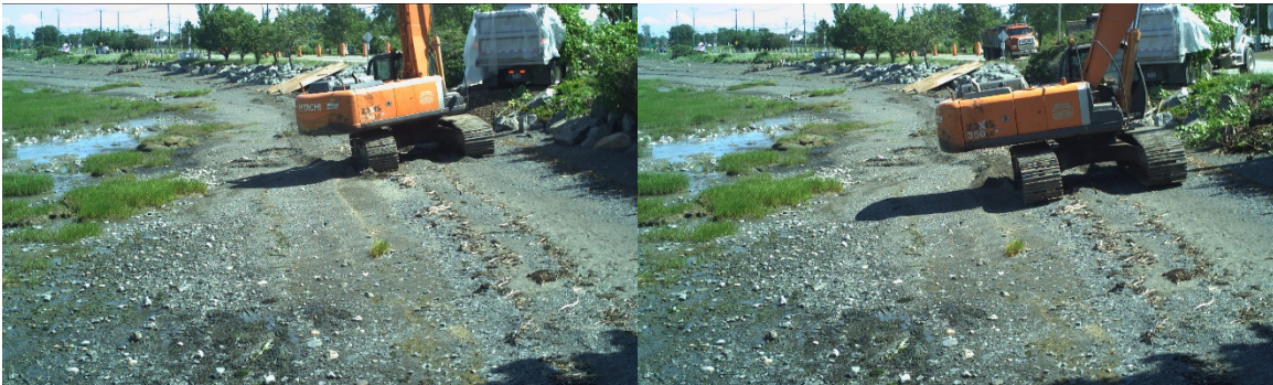
Figure 32. Excavation d'une colonie de renouée du Japon en 2018, Notre-Dame-du-Portage
