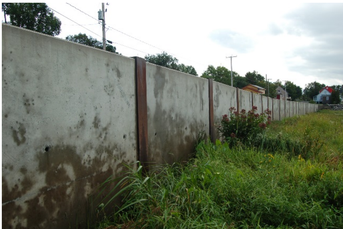
Figure 19. Muret de soutènement.
