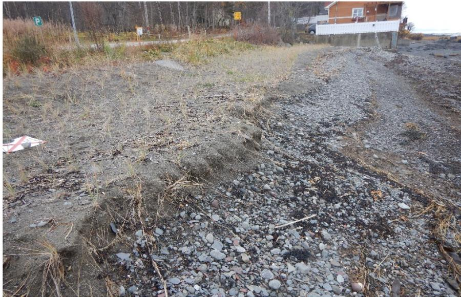
**Figure 20.** Érosion sur la face abrupte de la recharge sédimentaire et de la portion de sédiments fins.
