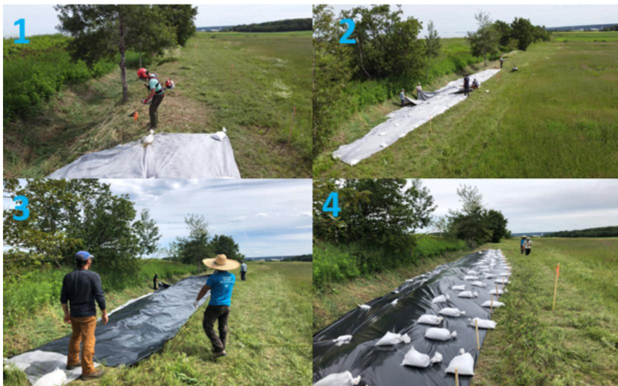
Figure 24. Étapes types pour l'installation des géotextiles et géomembranes. 1) fauche, 2) installation du géotextile, 3) installation de la géomembrane et 4) pose des sacs de sable.
