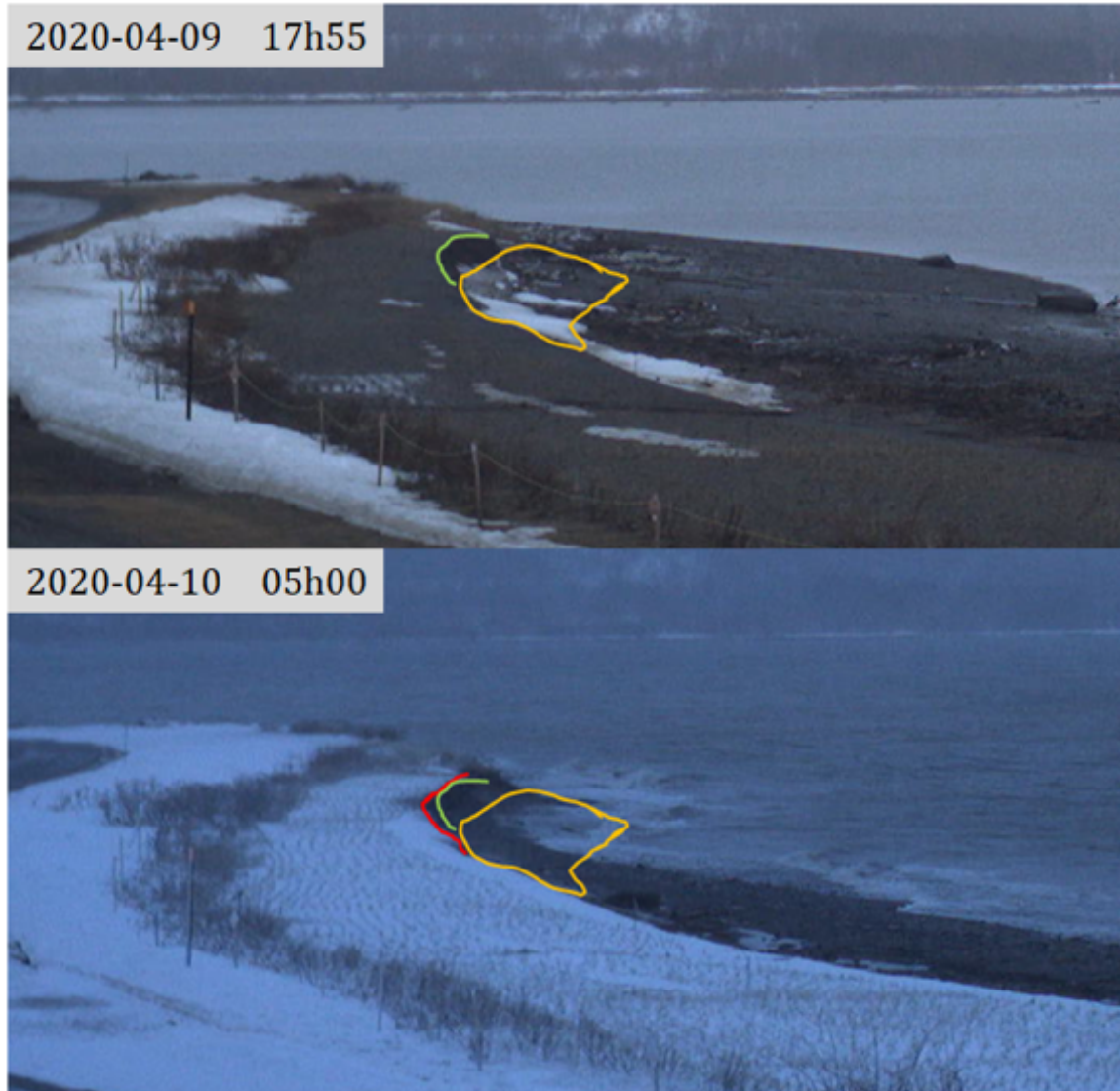
Figure 23. Changements observés à l'aide de la caméra Reconyx pour le secteur de la recharge sédimentaire en avril 2020.
