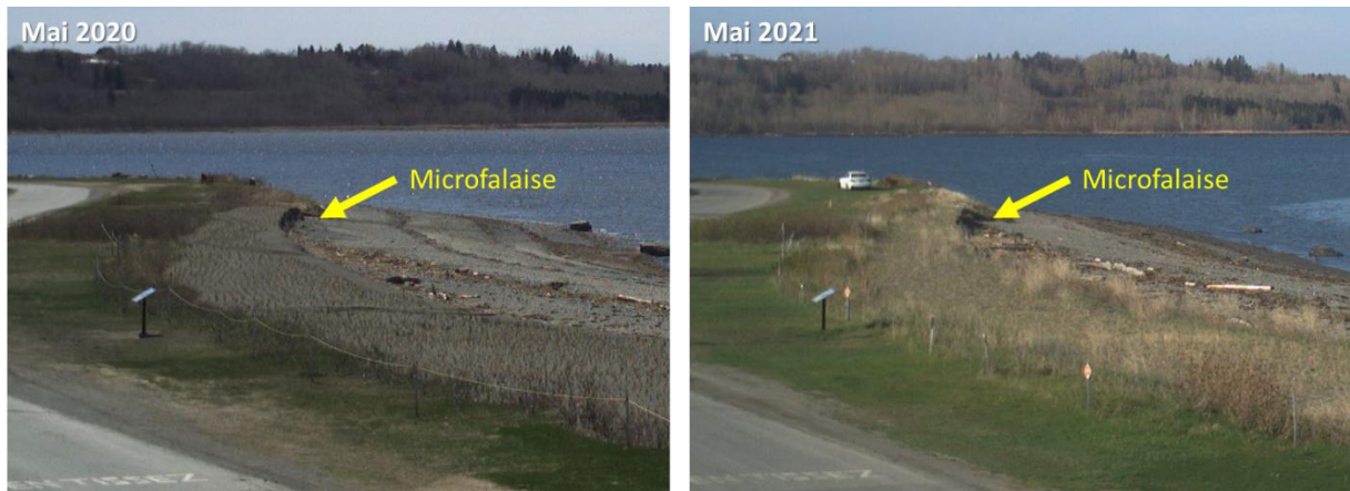
Figure 25 : Aperçu de la portion sud de la recharge entre mai 2020 et mai 2021.
