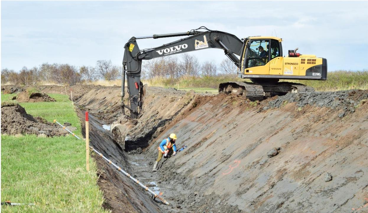
**Figure 9** Excavation et suivi des paramètres techniques (profondeur, pentes transversales et longitudinales) du canal de l'aboiteau.
