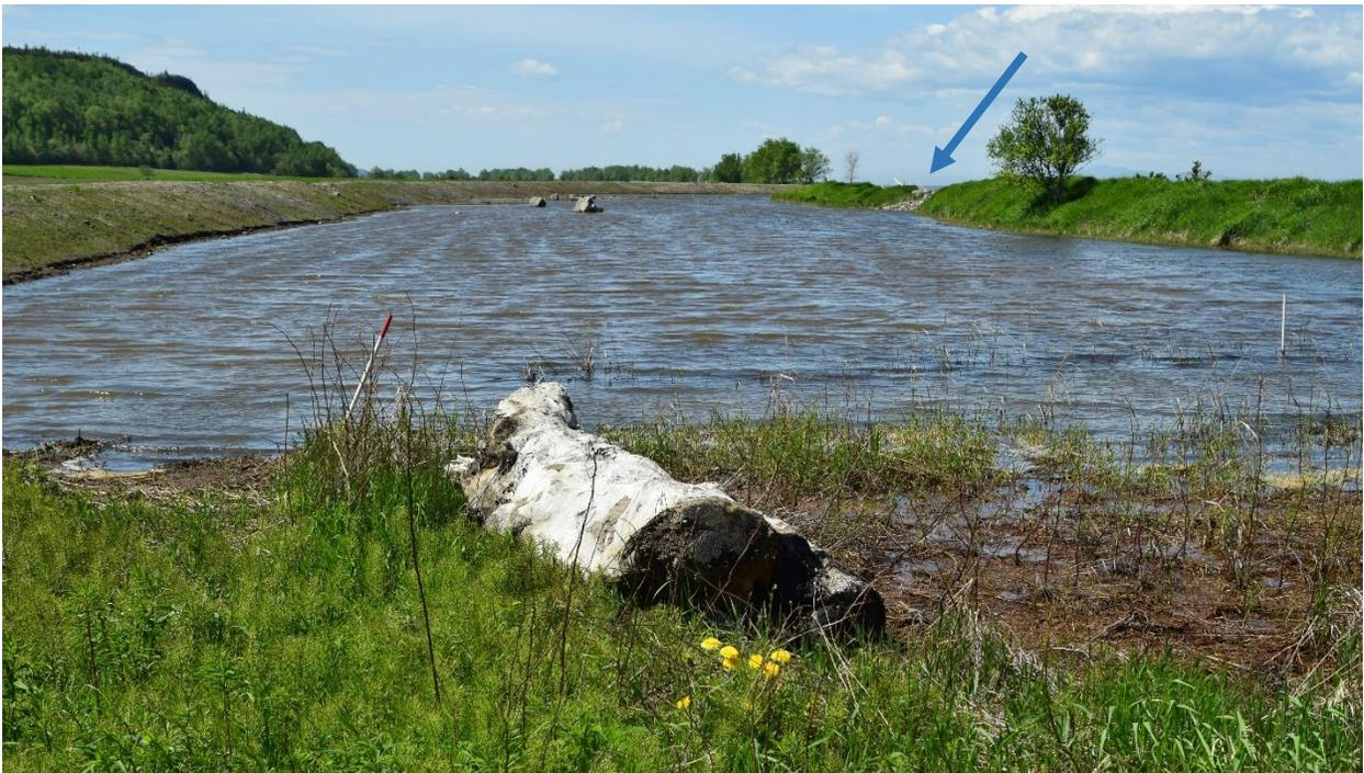
**Figure 26** Marais reconstitué en mai 2021. Notez le niveau d'eau élevé suivant le cycle de grande marée printanière. Le déversoir de l'ouverture consolidée est visible en arrière-plan (flèche).
