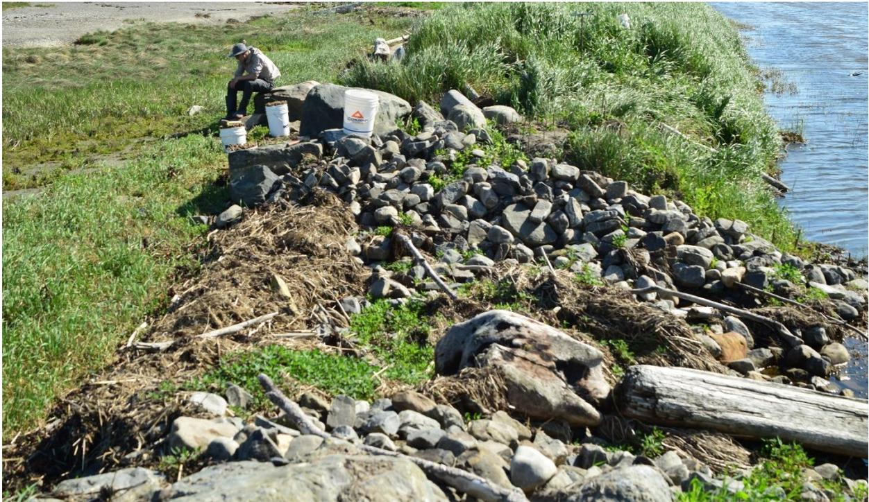
**Figure 30 Ouverture consolidée en juin 2021. Plusieurs débris ligneux et laisses de marées se sont déposés sur le tablier après les grandes marées automnales et printanières.**
