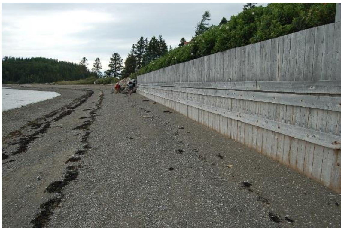
Figure 16 : Muret de bois sur la plage au sud du site de restauration projeté.
