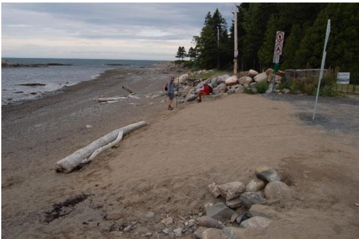
Figure 20 : Remblai de sable temporaire mis en place par la ville de Rimouski.
