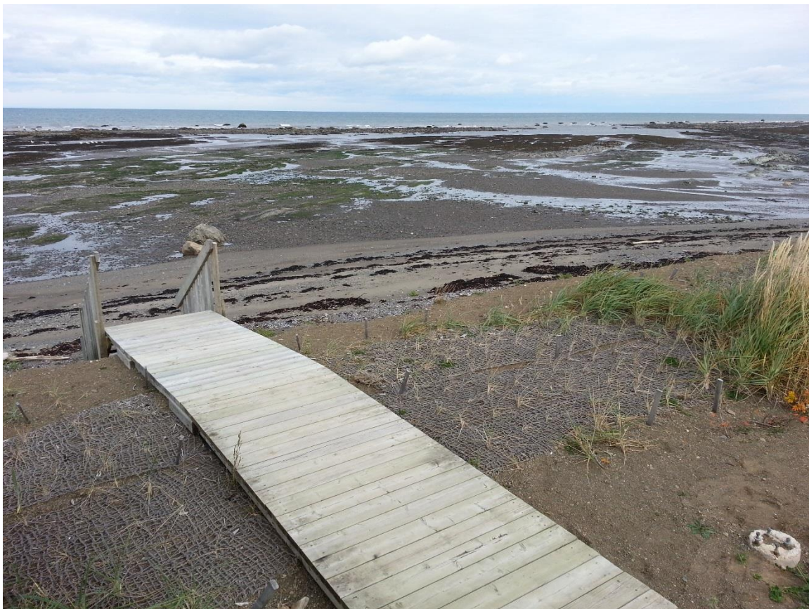
Figure 31 : Trottoir de bois sur la recharge de plage végétalisée de Sainte-Flavie, réalisée en 2013 par le Comité ZIPSE.
